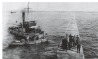
昭和8年7月31日に完工した沖ノ山南部防波堤
