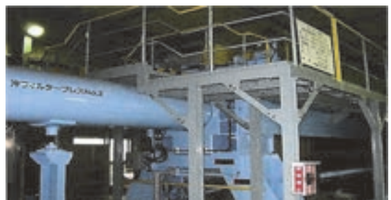
(廃液処理施設)
