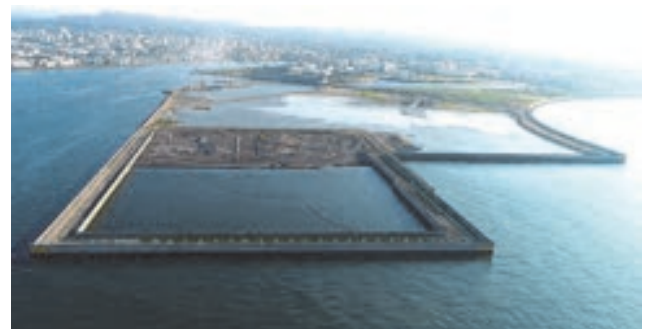
宇部港東見初広域最終処分場
