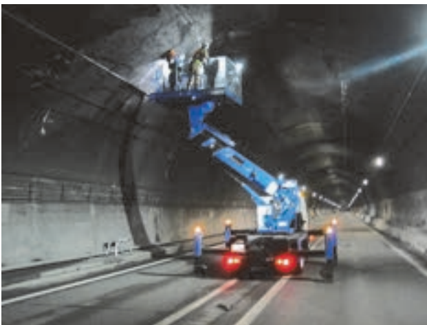
トンネル点検
